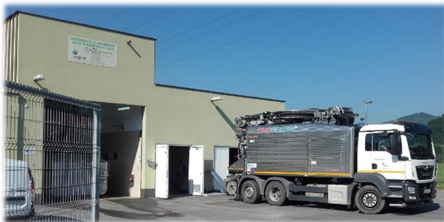
Slika: dovoz greznične gošče na CČN
