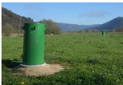
Bivše Odlagališče nenevarnih odpadkov Širjava s plinjaki opremljeni z BIO filtri
